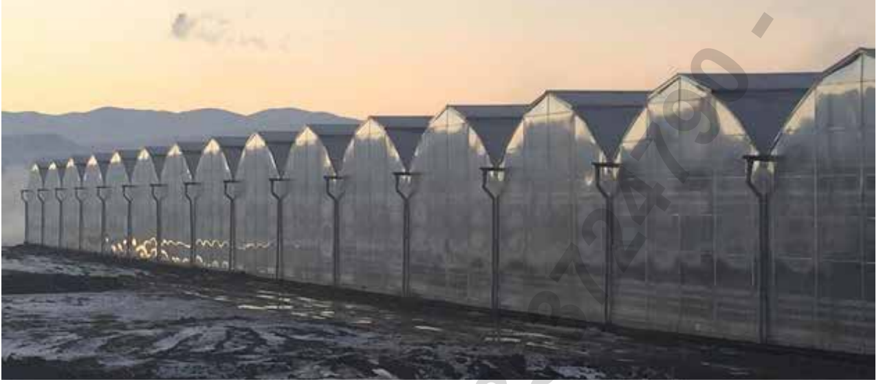
Şekil 5. Polikarbon Sera Yan Duvarları
