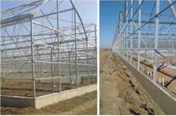
Şekil 2 . Çevre Temel ve Yan Perde Betonu
