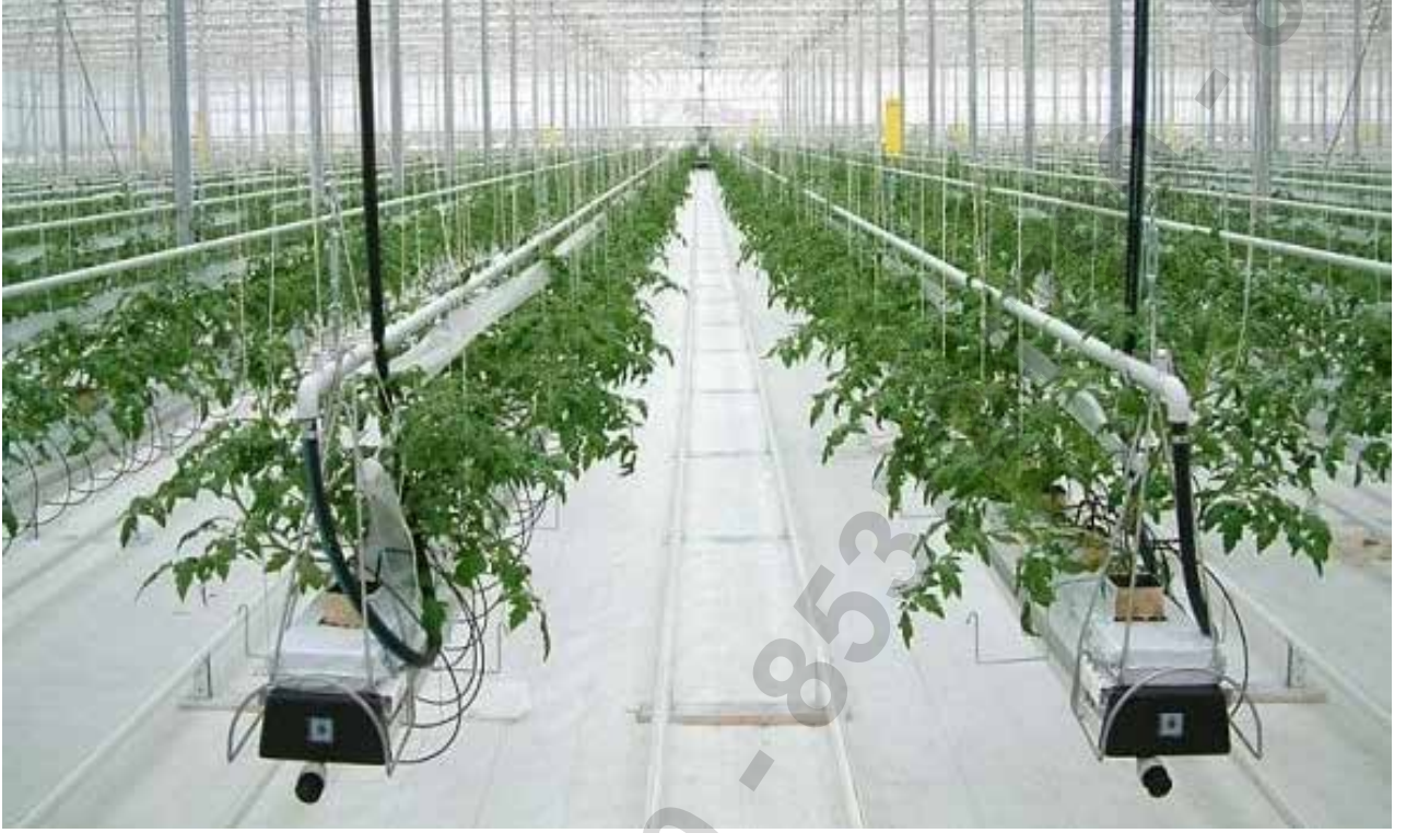
Şekil 12. Serada kullanılacak tabana yakın borulu ısıtma sistemi ve vejetasyon ısıtma
